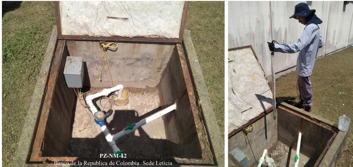
**Foto 4.** Sistema de bomba sumergible automatizado. PZ-NM-12. Leticia, Colombia. Fuente: OTCA & SHI SAS (2023).
