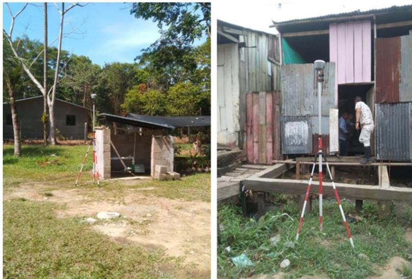
**Foto 24.** Levantamiento de puntos con el receptor móvil. Izquierda: sitio colindante al pozo sobre el que se realizó medición de nivel; derecha: lugar alternativo para medición del nivel base del terreno en pozo ubicado al interior de una edificación.
