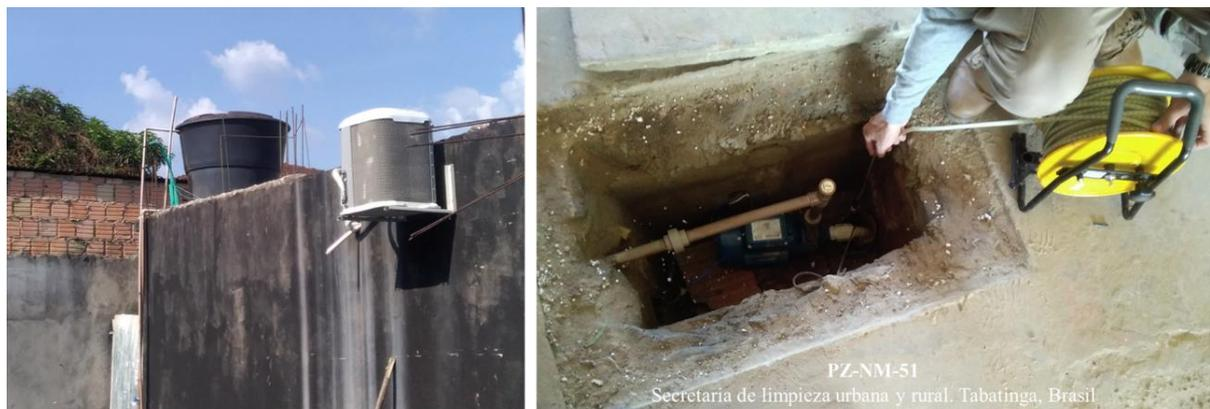
**Foto 5.** Sistema de extracción por motobomba e infraestructura de almacenamiento. PZ-NM-51. Tabatinga, Brasil. Fuente: OTCA & SHI SAS (2023).
